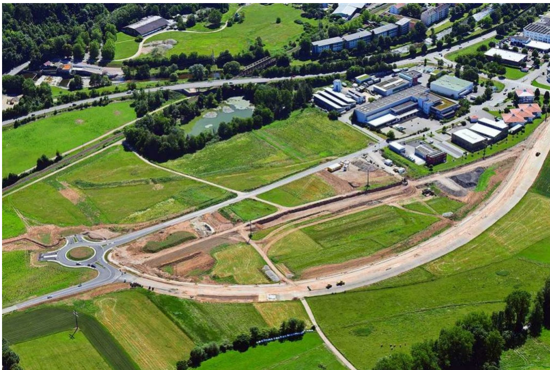
Der Bauplatz fürs künftige Zentralklinikum ist vorbereitet und soll über den ausgebauten B317-Anschluss Entenbad erreicht werden. Links im Bild die nach Steinen führende L138 und der neue Kreisverkehr. Foto: Erich Meyer
